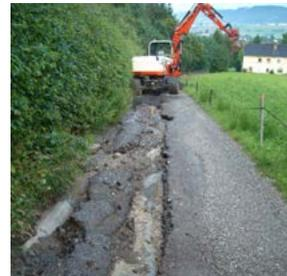
Bilder wie diese – mehrmals jährlich Schäden am Unterbau des Waldweges – sollen in Zukunft der Vergangenheit angehören.
